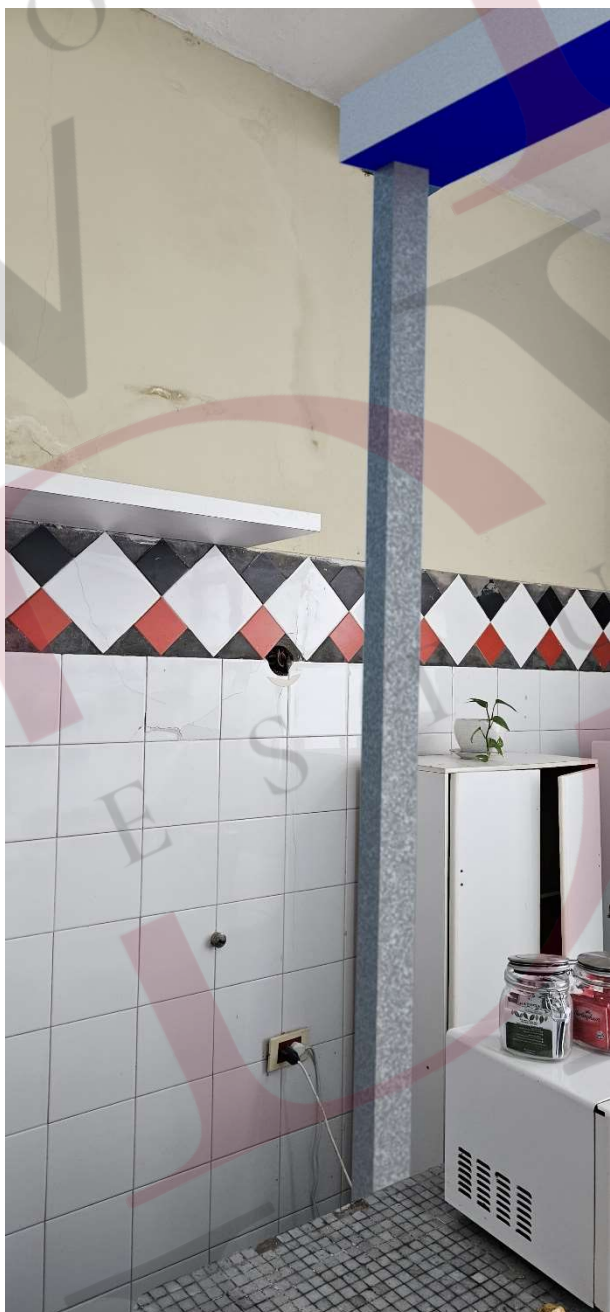
Imagen 3.3.2 – Esquema de ubicación columnas de refuerzo en laboratorio
